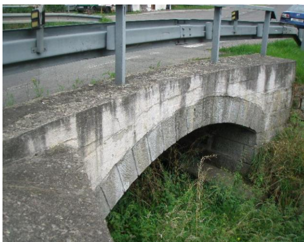
podélné trhlinky na boku římsy vpravo
