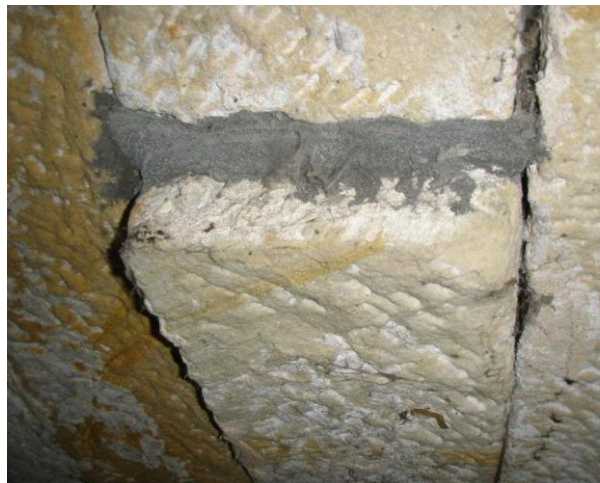
vysunutý kamenný kvádr v podhledu klenby
