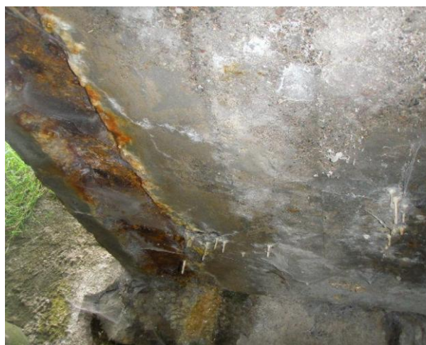
vápenité inkrustace a krápníky na podhledu NK
