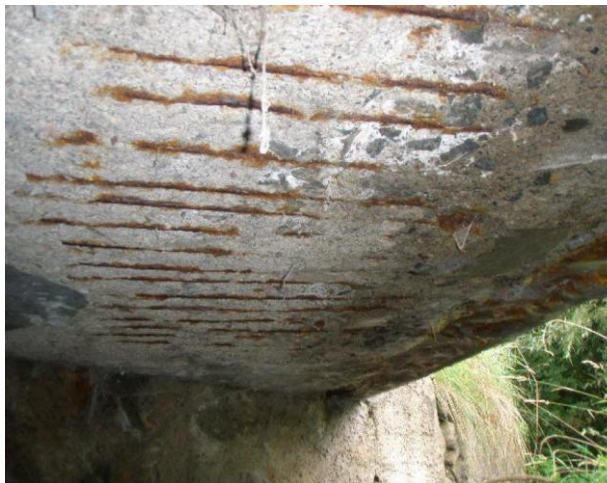
obnažená zkorodovaná výztuž na podhledu NK
