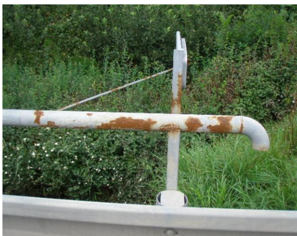
koroze zábradlí
