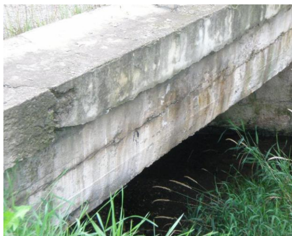
degradovaný beton římsy vlevo
